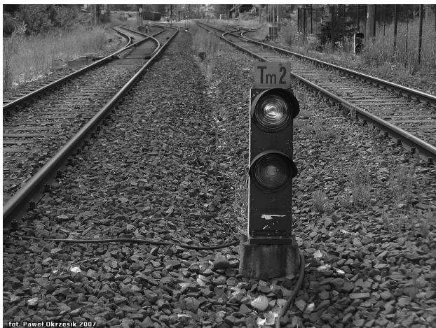
Rys. 6. Sygnalizator świetlny wraz z oprawą oświetleniową
