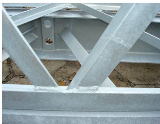
Rys. 5. Fragment słupa zabezpieczonego systemem DUPLEX
