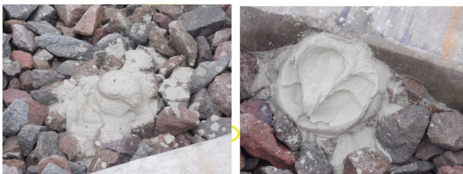
Rys. 3. Podsypka zanieczyszczona produktami lasowania [fot. G. Gawroński]
