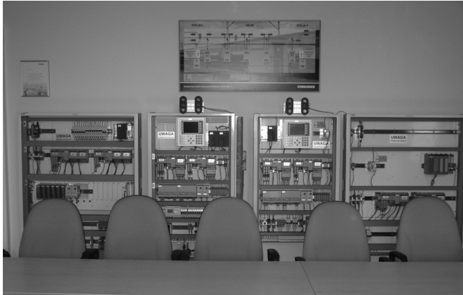
Rys. 3. Stanowisko laboratoryjne do nauczania sterowania komputerową blokadą liniową SHL-12 (z powtarzaczami semaforów odstępowych) i jej podzespołami [fot. M. Kornaszewski]
