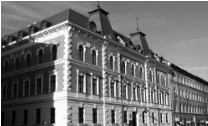
Rys. 5. Budynek Centrum Edukacji MÁV
