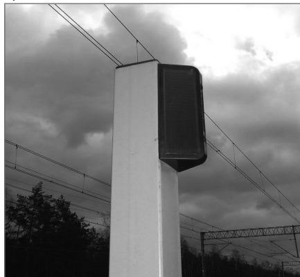
Rys. 5. Elementy odblaskowe: a) wygląd, b) wysokość mocowania (fot.: NEEL)
