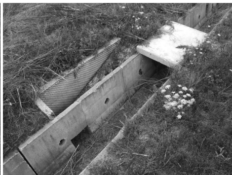
Rys. 2. Rozwiązania umożliwiające drobnym zwierzętom wyjście z głębokich elementów odwodnienia (fot. J. Żyłkowska)
