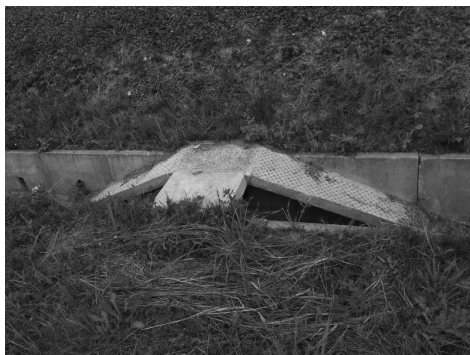
Rys. 2. Rozwiązania umożliwiające drobnym zwierzętom wyjście z głębokich elementów odwodnienia (fot. J. Żyłkowska)
