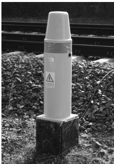
Rys. 6. Urządzenie akustyczne typu UOZ (fot.: NEEL)
