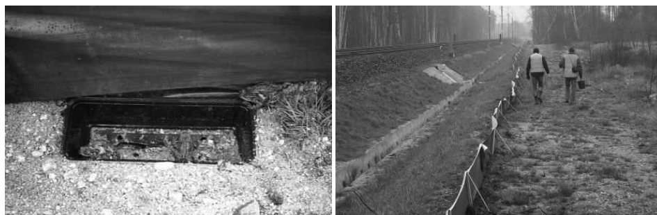
Rys. 3. Przenoszenie płazów przez tory na linii E-30 (fot. PKP PLK).
