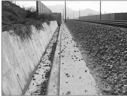
Rys. 15. Zjawisko wywiewania ziaren tłucznia podczas przejazdu pociągu z dużą prędkością [41]
