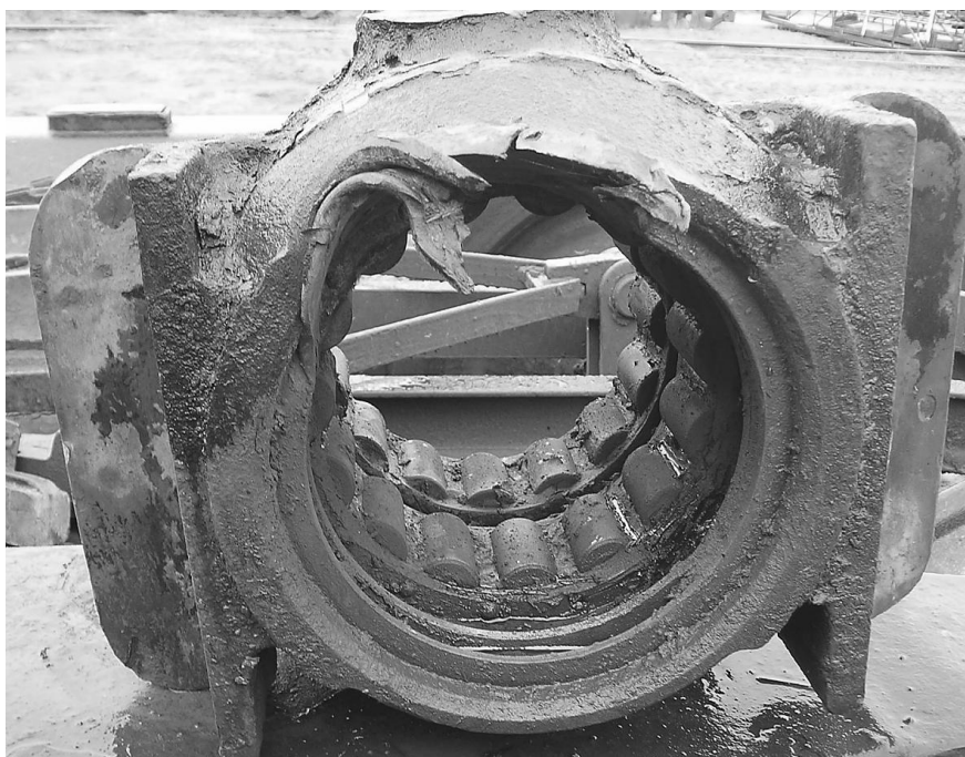
Rys. 2. Uszkodzone łożysko i korpus maźnicy
